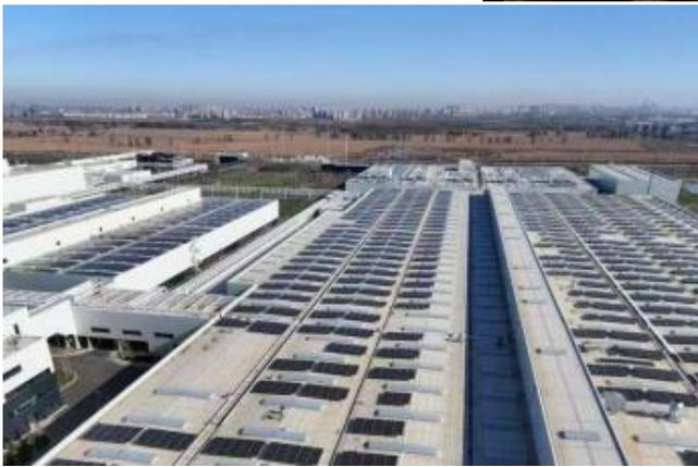
7.项目利用车间空余屋面放置光伏太阳能光伏板，采用能源合同管理模式，高效利用太阳能资源，电网联接方式：高压-低压并网，所有光伏发电厂区内内部消耗。
