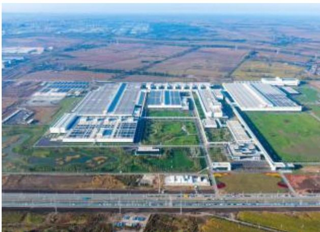
地面积 227873.30 m<sup>2</sup>，下沉式绿地率为 75.43%；可渗透地面面积为 17198.63 m<sup>2</sup>，透水铺装面积比率为 2.88%；同时，在园区设置了 7 处雨水调蓄模块，共计 12470.11m<sup>3</sup>，调蓄容积为 12096.01m<sup>3</sup>，蓄水模块主要调蓄内排水建筑屋面雨水及部分道路的路面雨水。
