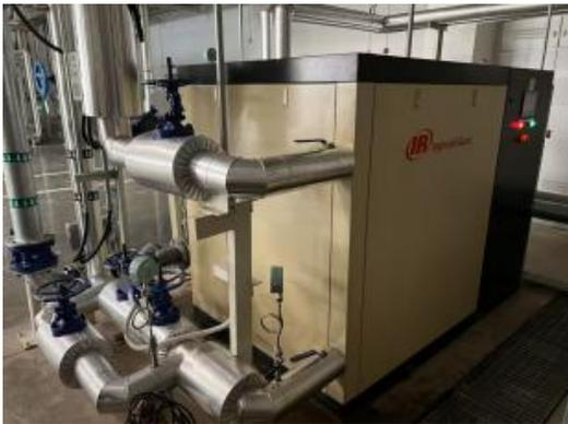
3.项目采用循环水余热利用，冬季利用制冷机的热泵功能回收循环水的余热用于采暖，项目螺杆式冷水机组开启热泵功能，作为水源热泵利用循环水池内余热，可回收热量为3MW。
