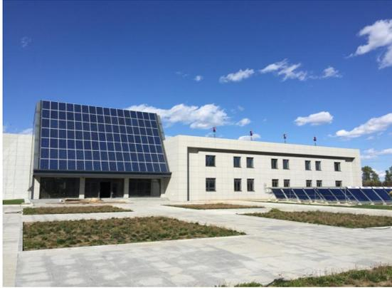
光伏板与实墙面对比鲜明，形成“建筑第五立面”。根据当地太阳日照资源条件，将坡屋顶角度设计为 $40^{\circ}$ ，最大程度接受光照提高发电量的同时，做到光伏板与坡屋顶的完美结合。本建筑可实现全天候发电，
