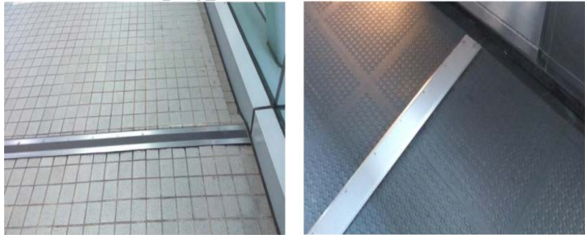
图 20 实桥伸缩缝照片
