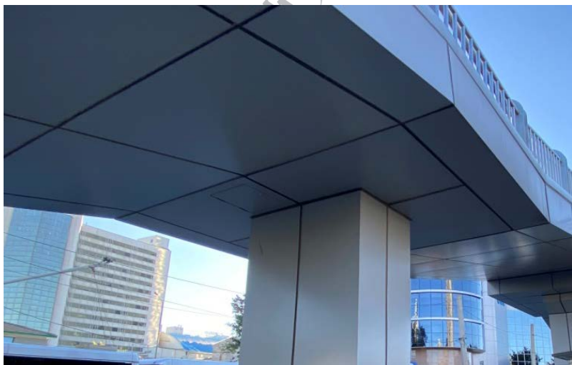
图 12 凹槽与线条方式装饰桥墩照片
