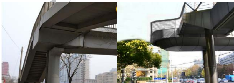
图8 梁端美化处理照片
