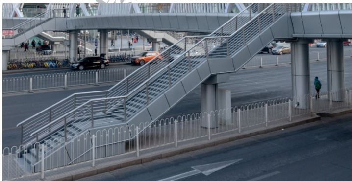
图 10 装饰板装饰桥墩照片
