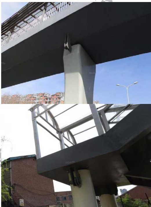
图 1 抗拉拔抗震措施示意图
