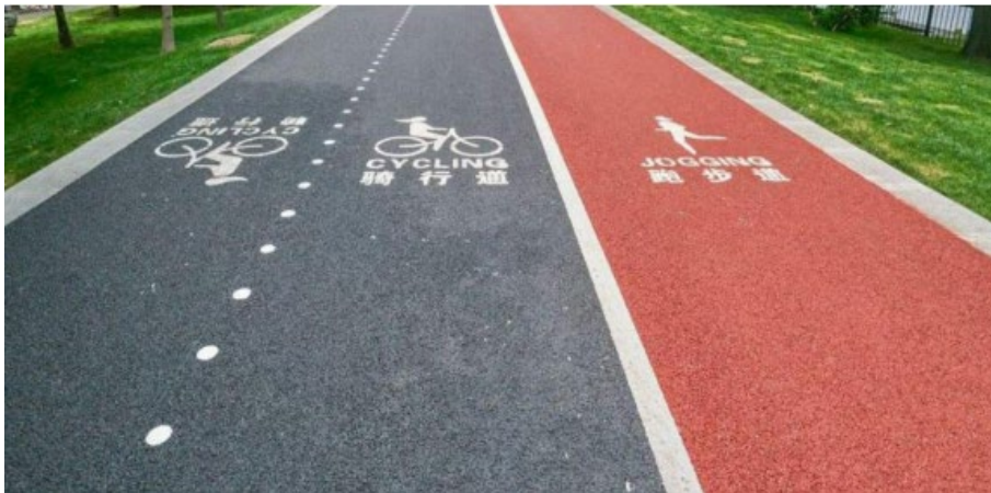
图 4-5 彩色透水混凝土铺装示意图
