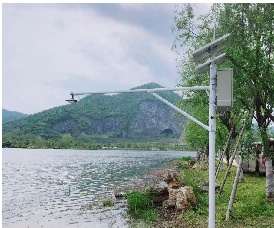
图 9-10 雷达式水位计立杆式安装现场图
