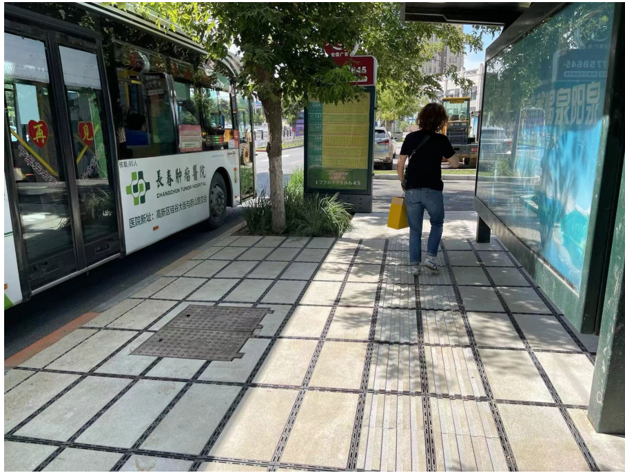
图 4-4 渗排板与仿石材缝隙型透水砖/花岗岩组合铺装示意图
