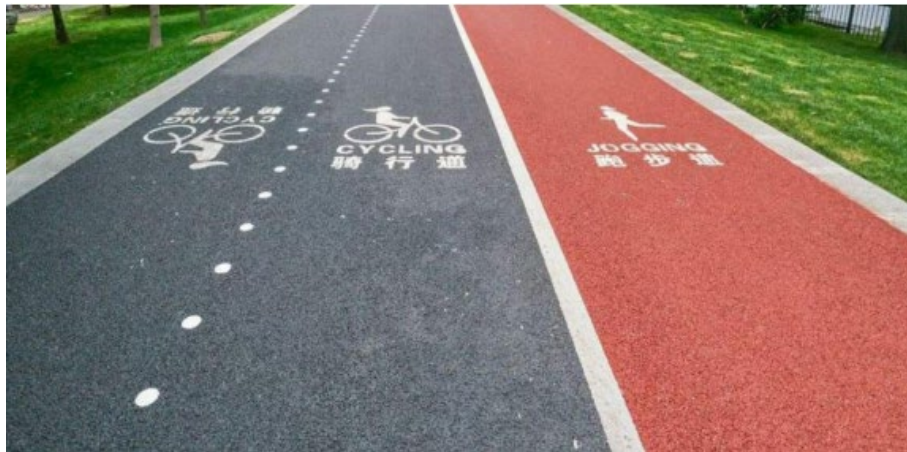
图 4-5 彩色透水混凝土铺装示意图
