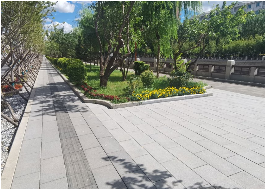
图 4-3 仿石材縫隙型透水砖铺装示意图
