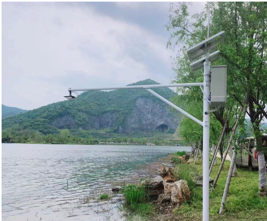
图 9-10 雷达式水位计立杆式安装现场图
