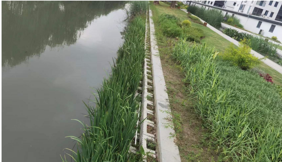
图 7-21 生态岸线—生态挡墙
