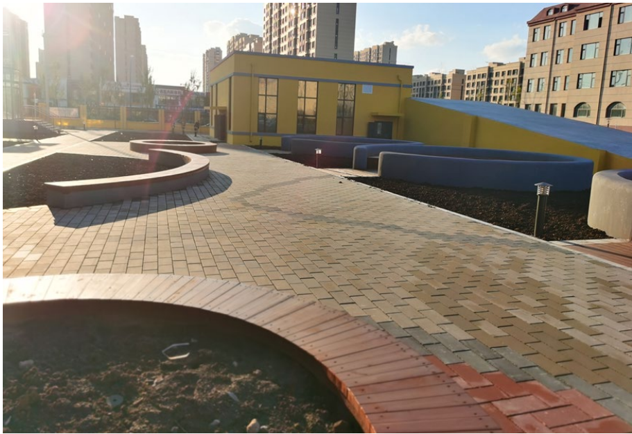
图 4-2 缝隙型透水砖铺装示意图
